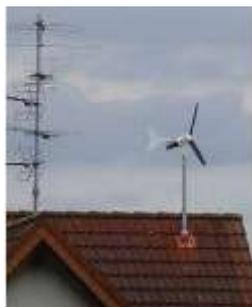
Gambar 14. Turbin angin skala kecil di pada atap rumah
